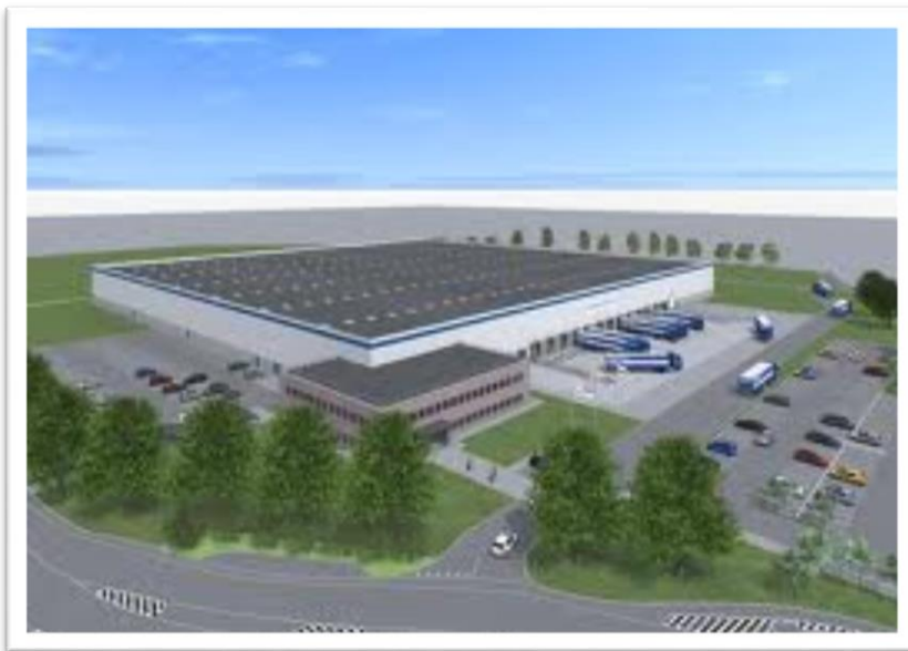
Centro de Distribución
